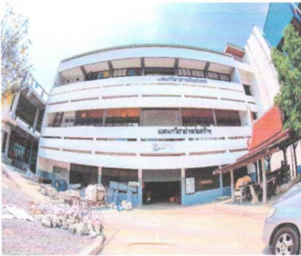
อาคาร ๖
