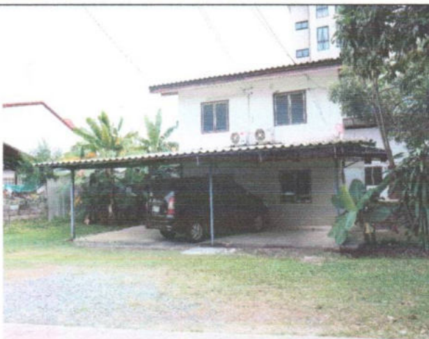
อาคารบ้านพักผู้อำนวยการ
