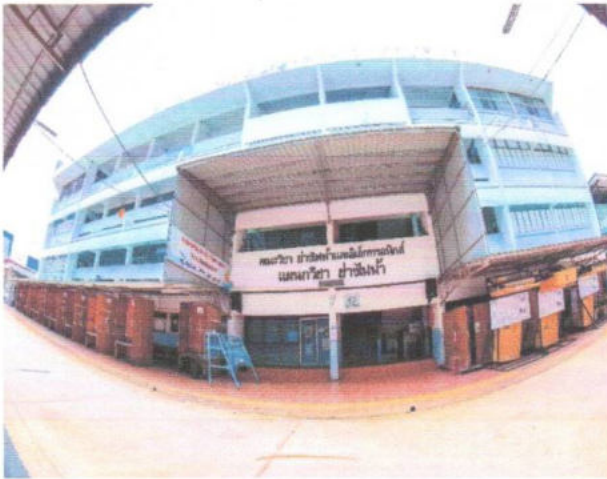
อาคาร ๗ แผนกวิชาไฟฟ้ากำลัง
