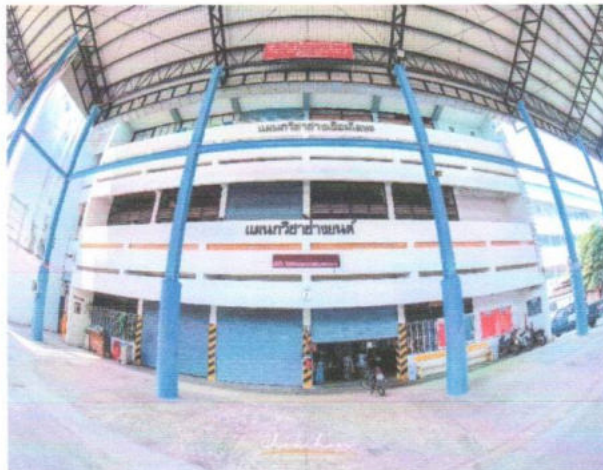
อาคาร ๖
