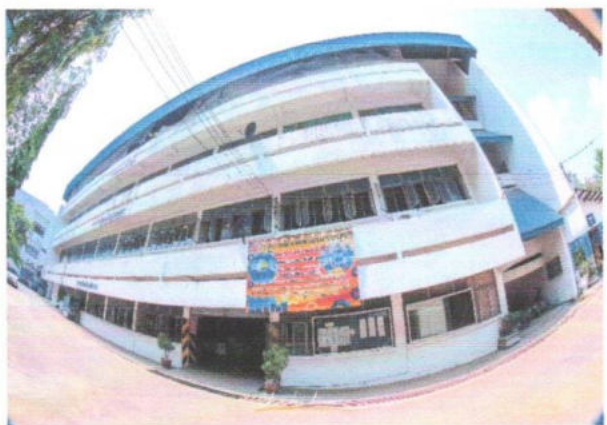
อาคาร ๘
